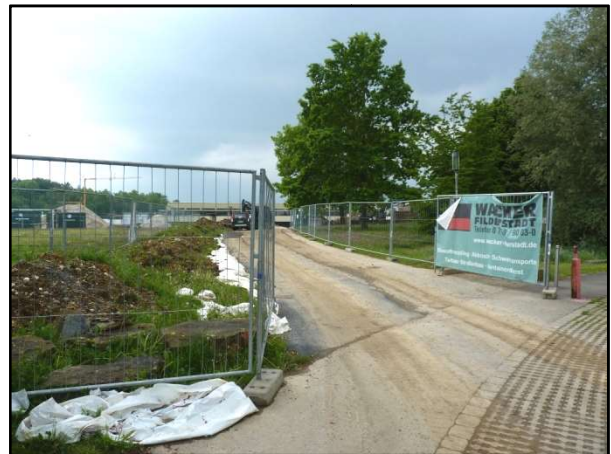
Abb. 9 Baustellenzufahrt am Südrand des Areals.
